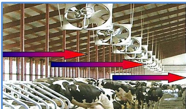
Рисунок 33 – Схема размещения циркуляционных вентиляторов
