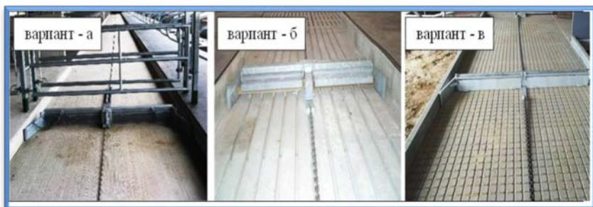
Рисунок 15 – Варианты конструкции пола кормонавозных и навозных проходов
