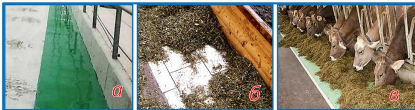
Рисунок 59 – Кормовой стол с полимерным покрытием (а); с покрытием из керамической кислотоустойчивой плитки (б); с рулонным полимерным покрытием (в)
