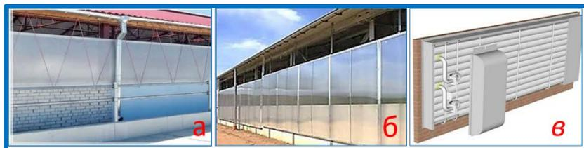
Рисунок 30 – Варианты установки штор на приточных вентиляционных проёмах
